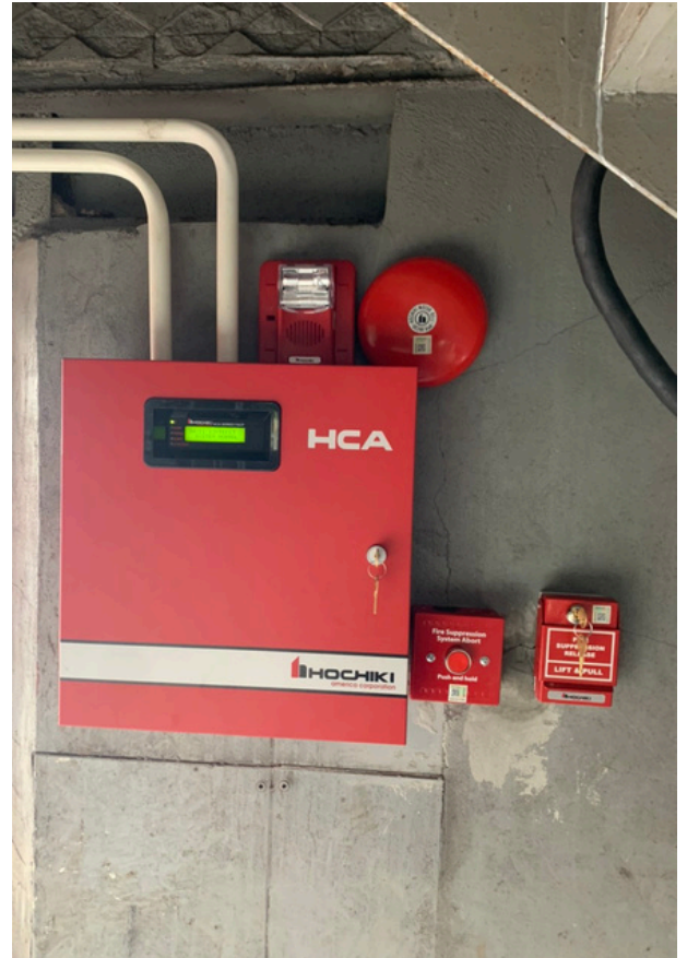
LẮP ĐẶT TRUNG TÂM BÁO CHÁY
