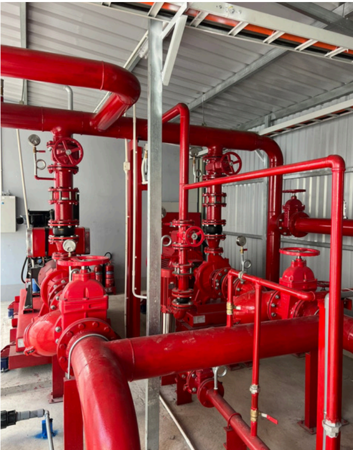
LẮP ĐẶT BƠM CHỮA CHÁY
